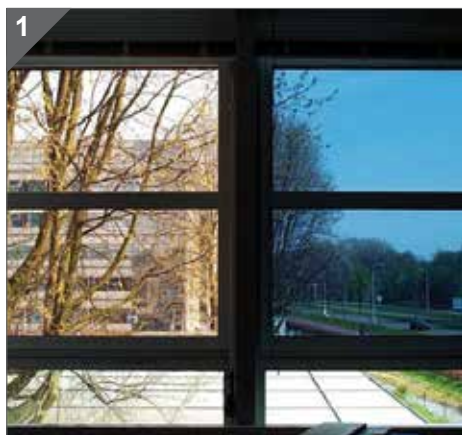
El acristalamiento electrocrómico varía del estado color (a la derecha) al blanqueado (izquierda).
