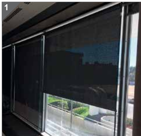
Control solar con tejido técnico enrollable exterior motorizado de color oscuro.
