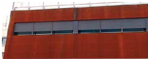
Toldo exterior negro micro-perforado y automatizado. 75% bajado.
