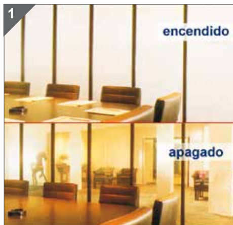
Vidrios inteligentes: se coloca una película de cristal líquido entre los cristales.
