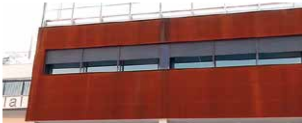
Toldo exterior negro micro-perforado y automatizado. 50% bajado.
