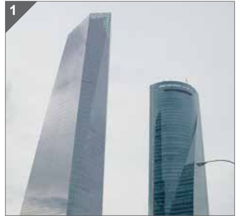
La elección del cristal determina la cantidad de luz transmitida y reflejada hacia el exterior.
