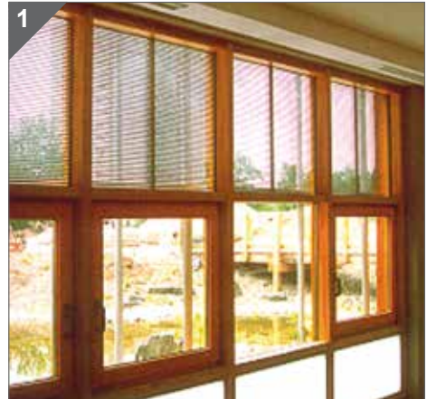
El dintel de la ventana, las jambas y los travesaños proporcionan un aspecto diferente.
