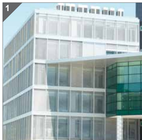
Control Solar Automático exterior. Centro I+D. Málaga.
