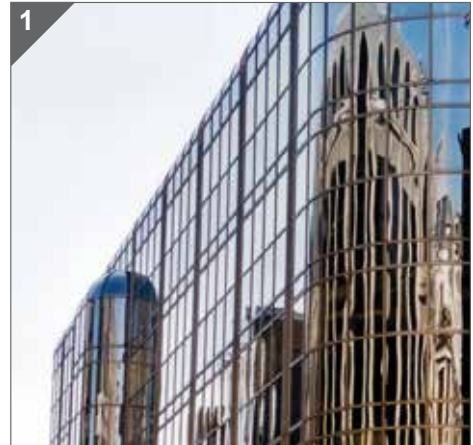
El acristalamiento reflectante actúa como un espejo reflejando sobre los edificios cercanos.
